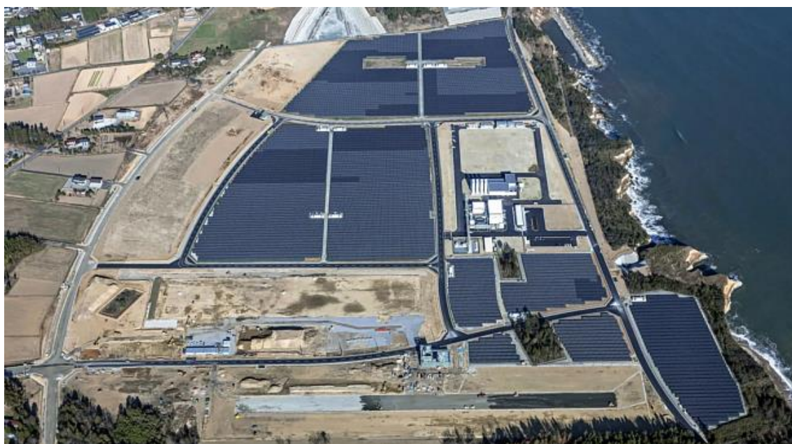
Водородная электростанция в городе Намиэ (Япония) // http://21mm.ru/news/high-tech/v-yaponii-zapustili-krupneyshuyu-v-strane-vodorodnuyu-elektrostantsiyu/
