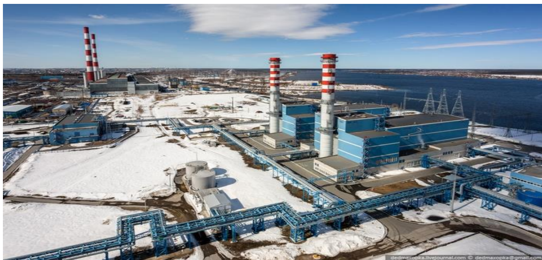
Сургутская ГРЭС-2 (на заднем плане Сургутская ГРЭС-1) https://rosphoto.com/ublogs/surgutskaja_gres-2-1854
