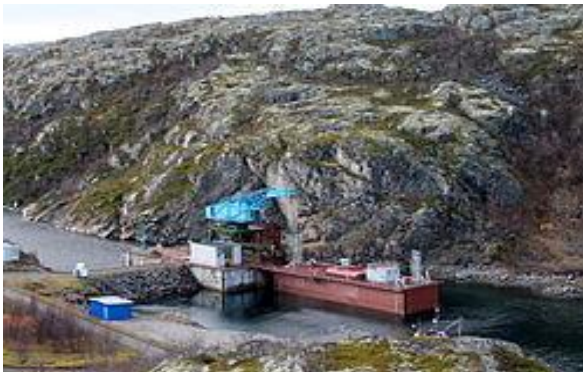
Кислогубская приливная электростанция (ПЭС), расположенная в Мурманской области, залив Кислая губа Баренцево моря // https://ru.wikipedia.org/wiki/Кислогубская_ПЭС
