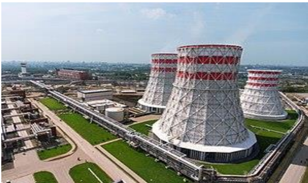
Челябинская ТЭЦ-4 (теплоэлектроцентраль в Челябинской области, основное топливо – газ) // https://ru.wikipedia.org/wiki/Челябинская_ТЭЦ-4
