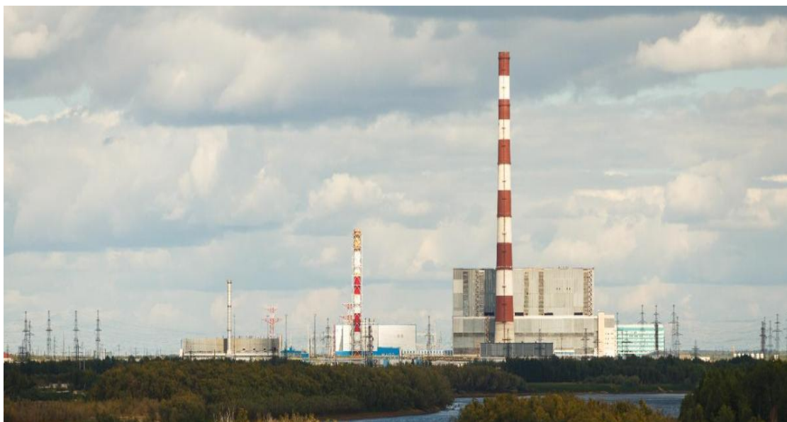
Нижневартовская ГРЭС// irao-generation.ru/stations/nvartg/
