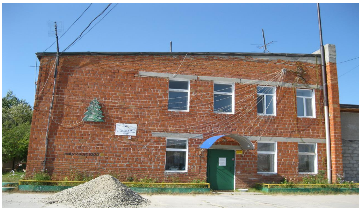
Офисное здание АО «Городские электрические сети» в п. Высоком (сетевой район №3)
